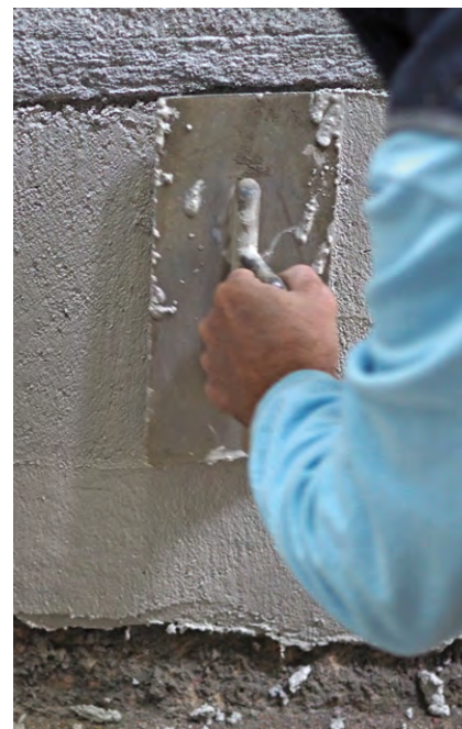
1. Prepararea mortarului. 2. Aplicarea mortarului de tinci. 3 & 4. Drișuire.
