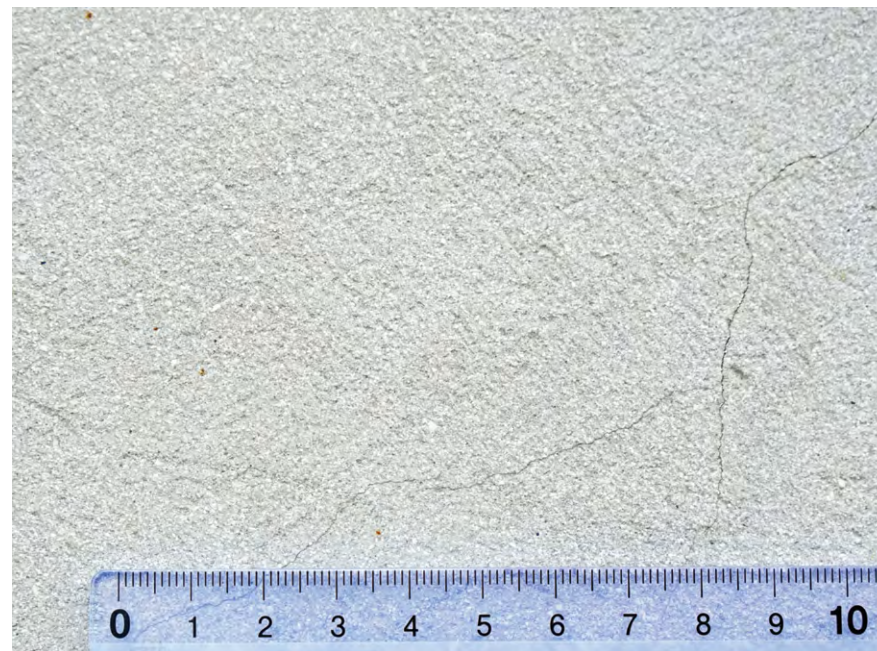
1. Imobil din Intrarea Filioara nr. 2. 2. Tencuială driscuită. 3. Detaliu cu scala 1:1 a texturii.
