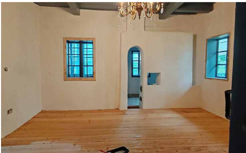
Pag. 24. Casa George Enescu din Mihăileni - reparația pardoselii după eradicarea infestării biologice, primăvară 2025, foto arhiva Pro Patrimonio
