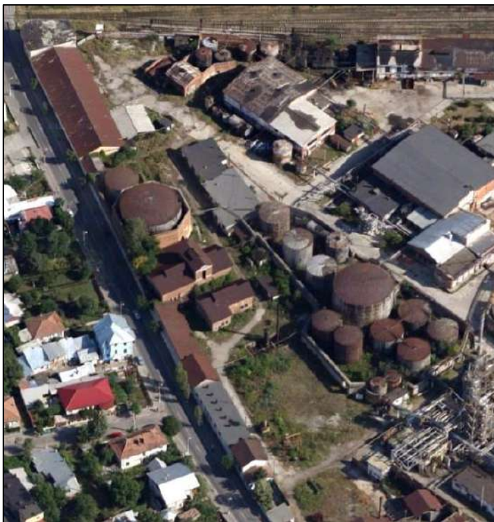
Zona auxiliară a Secției Parafină. Sursa: captură Google (vedere oblică dinspre S)
