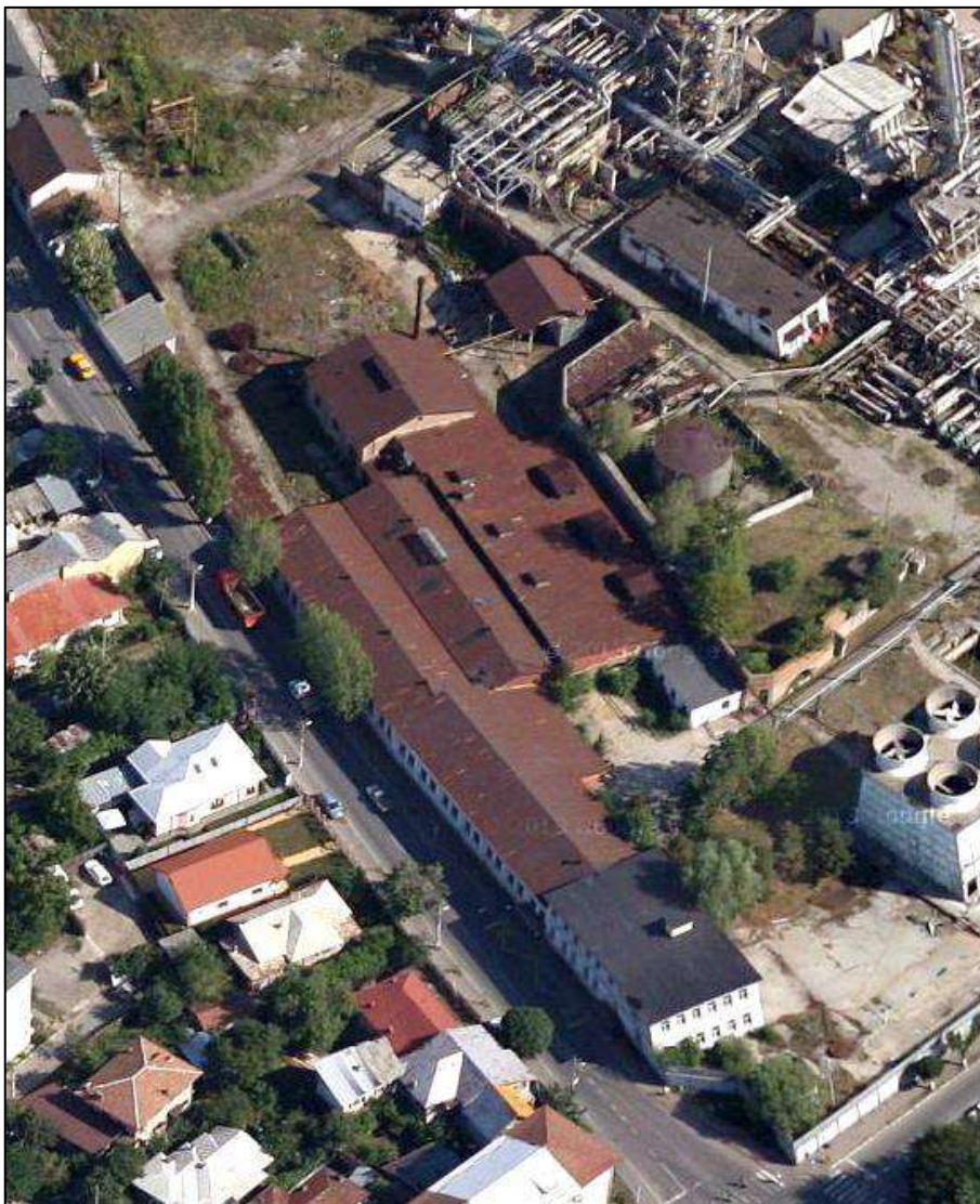
Zona atelierelor. Sursa: captură Google (vedere oblică dinspre S)
