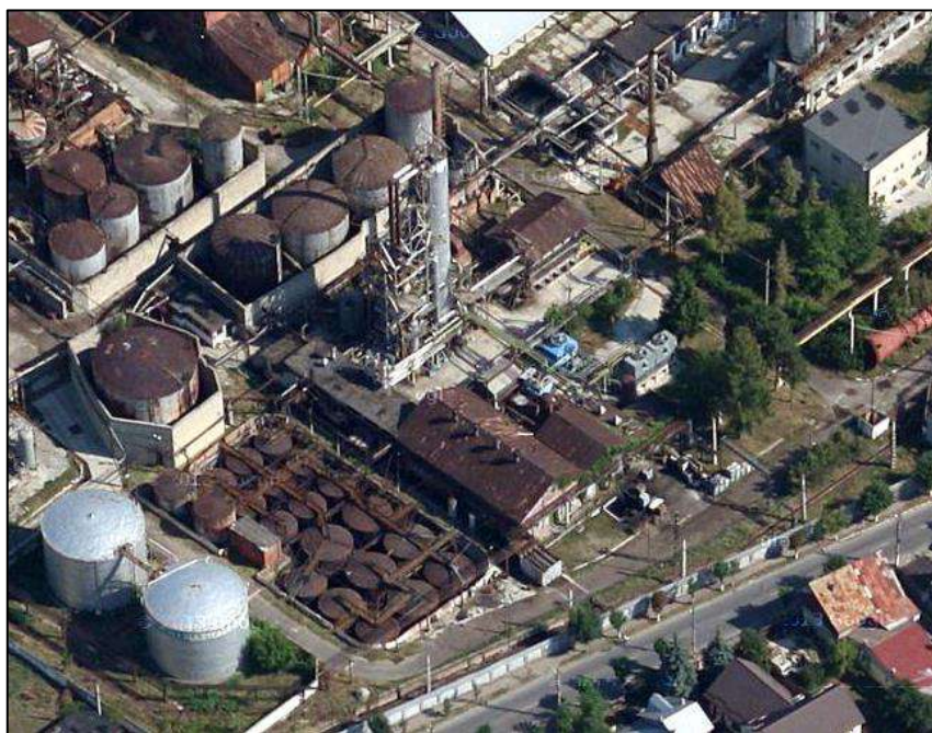
Platforma distilației în vid (DV1). Sursa: captură Google (vedere oblică dinspre S)
