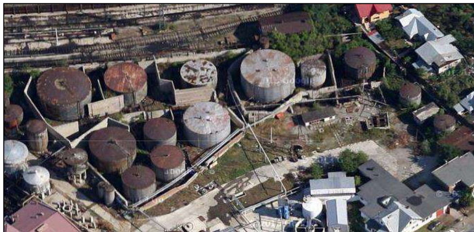
Zona rezervoarelor-depozit. Sursa: captură Google (vedere oblică dinspre S)
