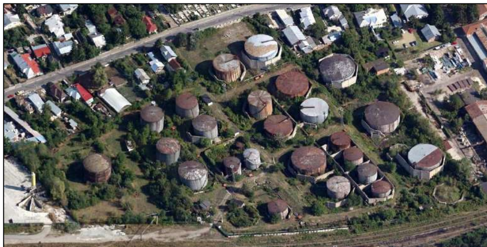
Grădina de rezervoare. Sursa: captură Google (vedere oblică dinspre S)
