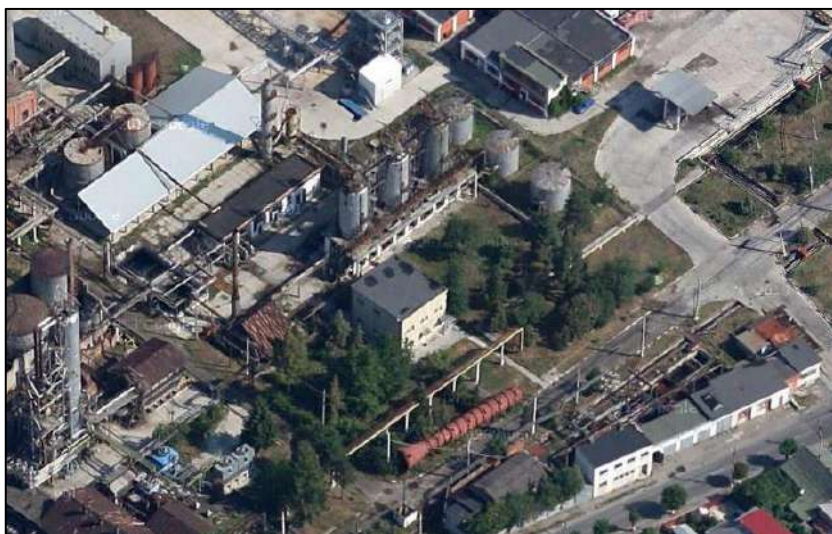
Platforma instalației Bitum. Sursa: captură Google (vedere oblică dinspre S)
