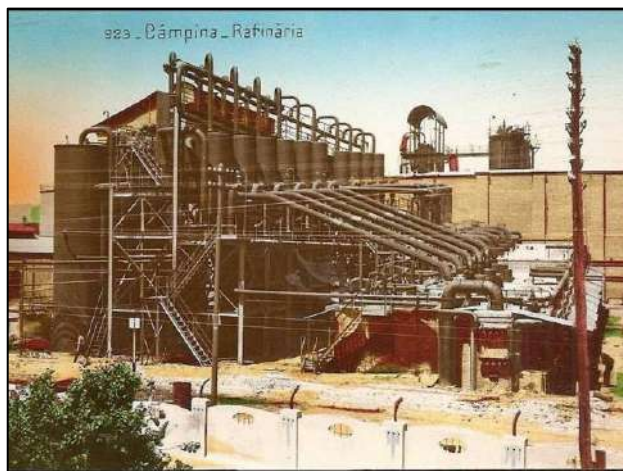
Fig. 8 / 9: Bateria „Allan” pentru distilarea țițeiurilor parafinoase, pusă în funcțiune la 1927, care a fost distrusă în Al Doilea Război Mondial. Sursa: „Petroblog” / Studenți aflați în practică în cadrul rafinăriei, la 1936. Sursa: ANPH, fond Eremia Grigorescu – Decebal Grigorescu, fotografii, ds.175
