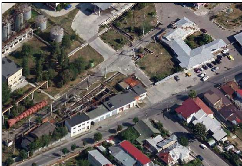
Zona administrativ-tehnică nouă. Sursa: captură Google (vedere oblică dinspre S)
