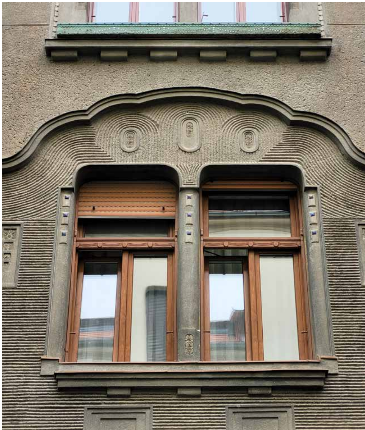
Detaliu de fațadă, Palatul Dauerbach, Timișoara. Foto: Ruxandra Sacaliș.
