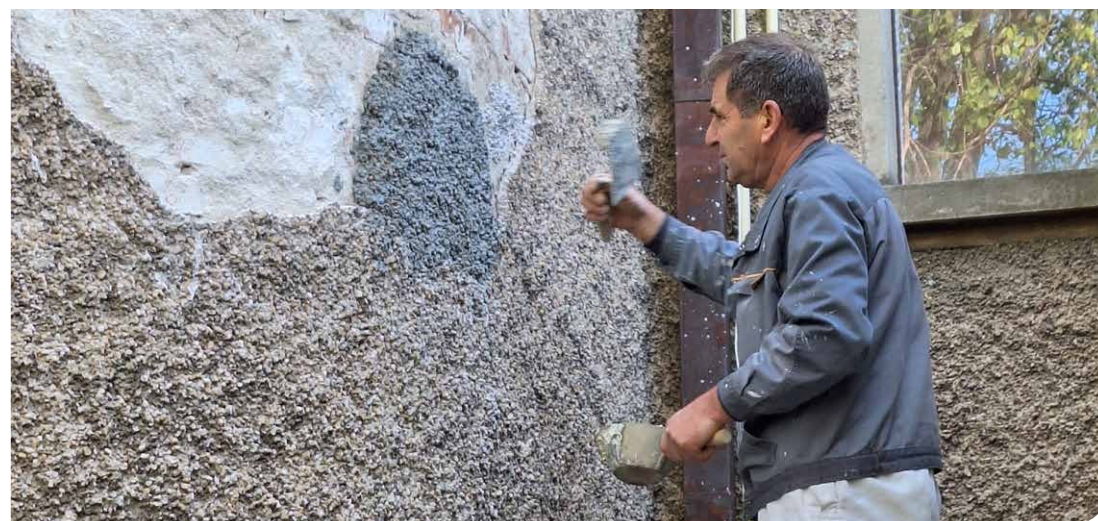
1, 2. Curățări de fațade, aspecte ale proiectului de cercetare Tencuieli Istorice, foto arhiva Pro Patrimonio.
