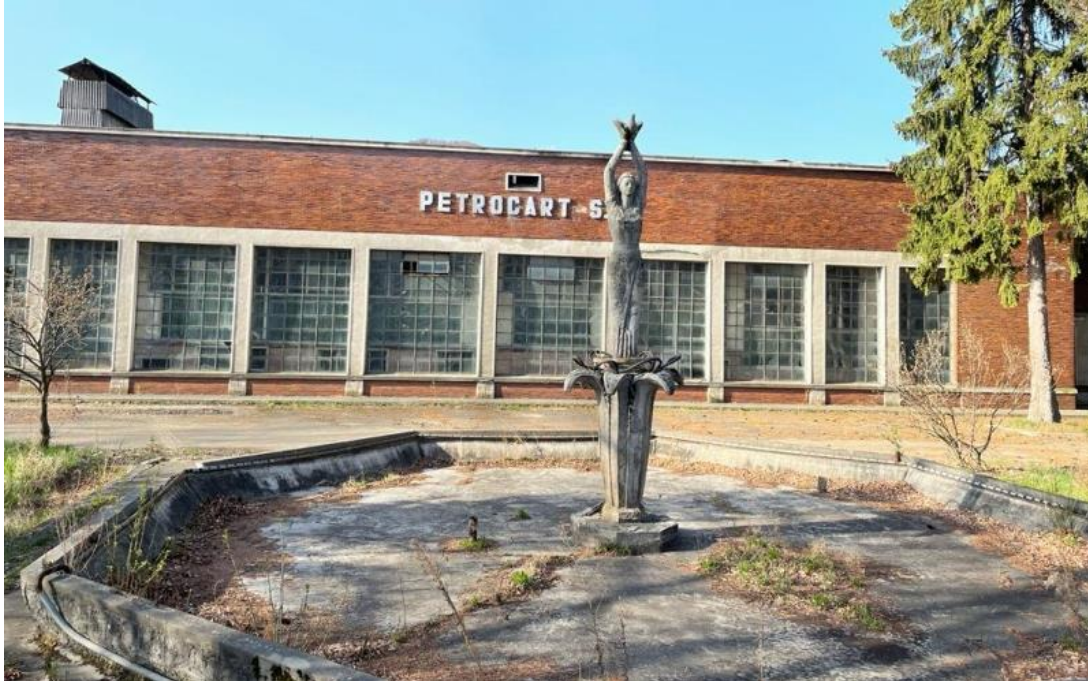
Fig. 4 – Imagine de arhivă dinspre Nord
