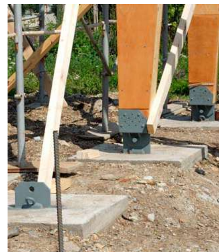
Detaliu prindere baza stâlp – fundație
