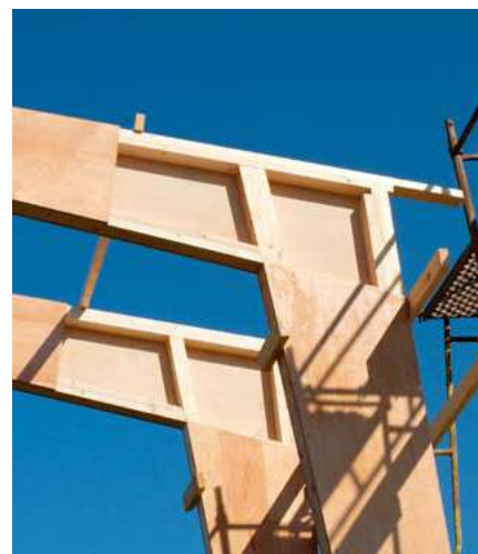
Detaliu prindere stâlp – grindă
